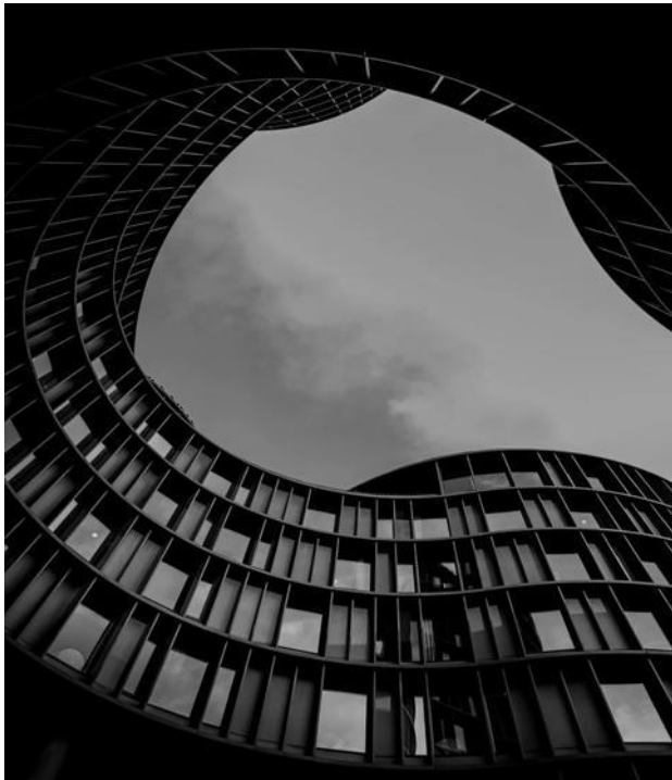
Mynd 20: Framhlið Axel Towers í Kaupmannahöfn, Danmörku
